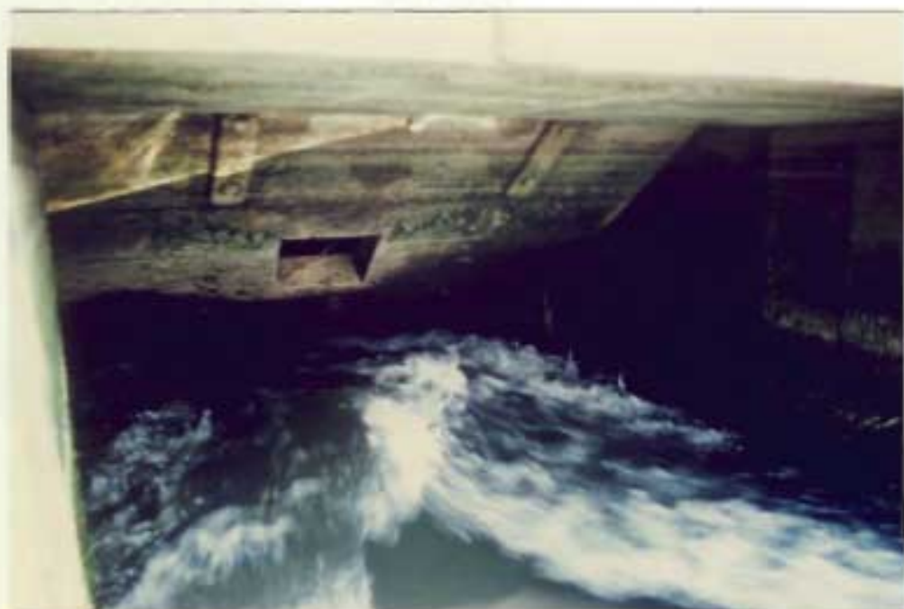
Photo 12 : La porte à clapet de l'épi-buse de Pourville sur la Saône.
