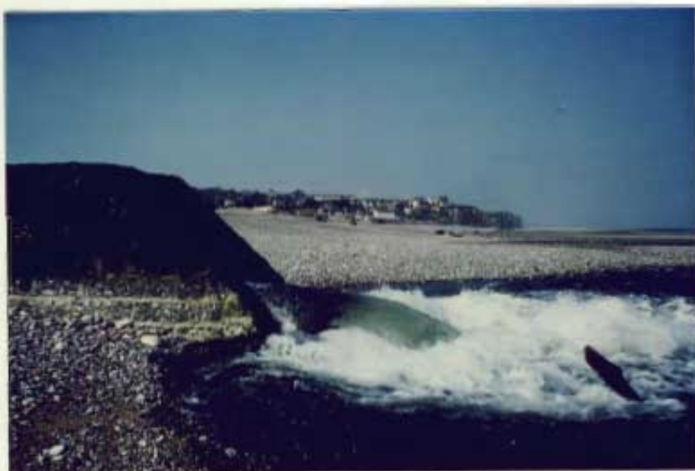
Photo 11 : L'épi-buse d'évacuation en mer d'eaux de la rivière Saône à Quiberville.
