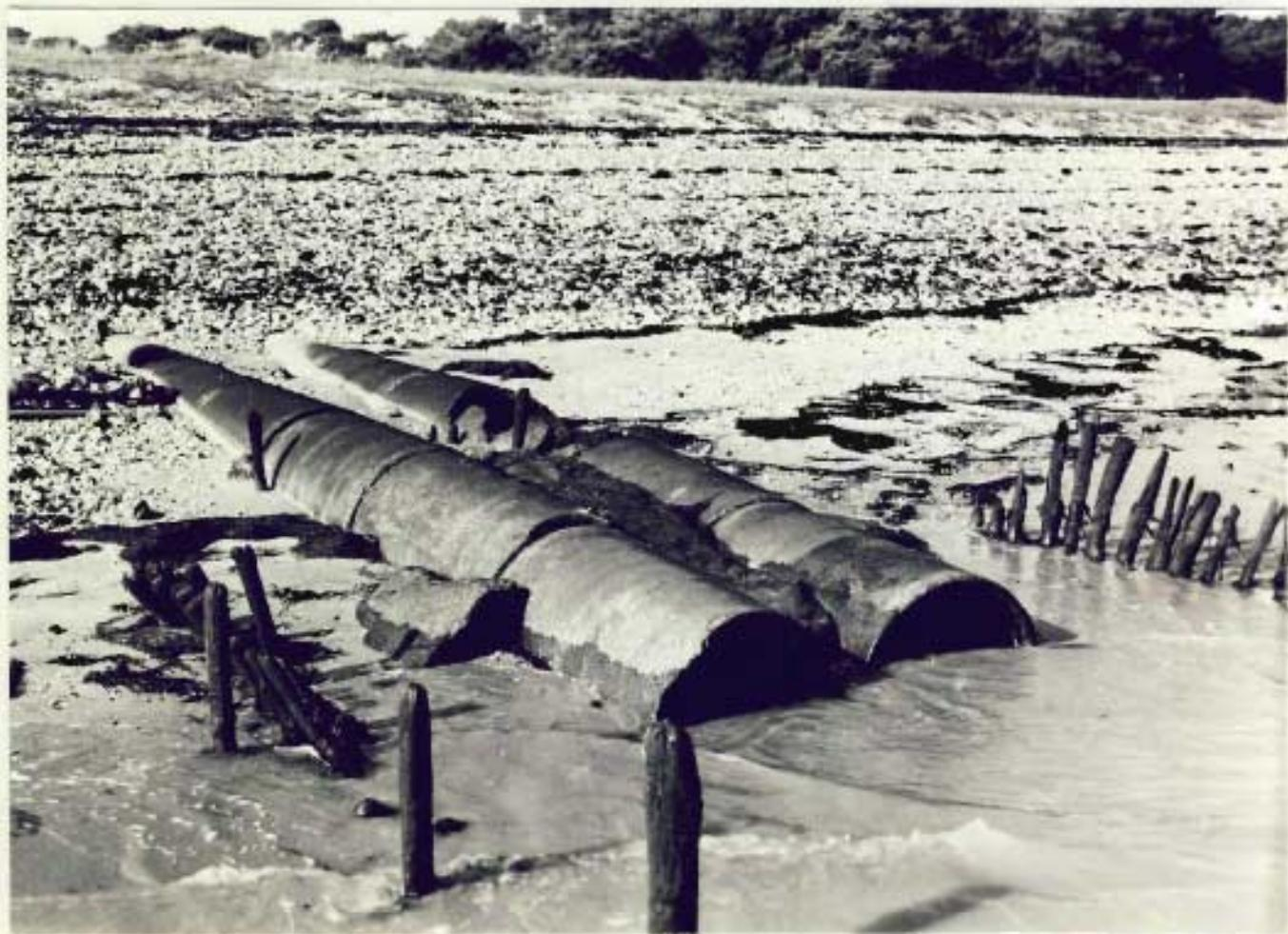
Photo 8 : Buses d'alimentation traversant la dune (vanne nord).
