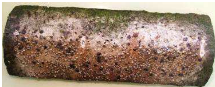
Photo 1 : Tuile chaulée collectée en octobre 2010.
