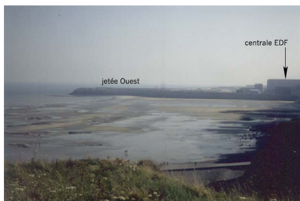
Figure 4.50 - Accumulation de sable contre la jetée ouest de la centrale EDF de Penly (Costa, 1997)
