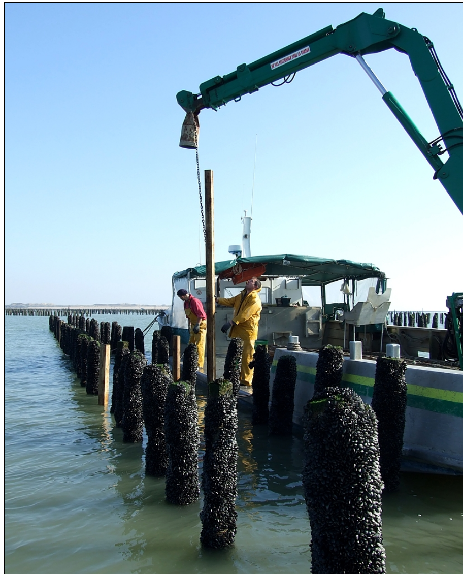
Pose d'un pieu sur un bouchot dans le Pertuis Breton Photo LER/PC - AS
