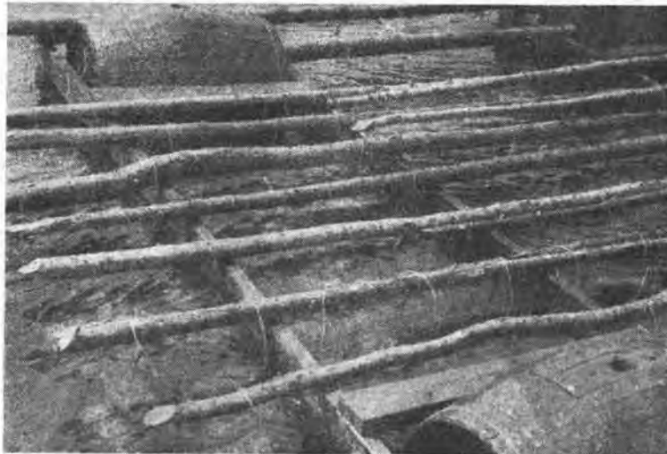
Fig. 5. — Radeau à collecteurs en bois de Malpègue ( Ile du Prince Edouard )
