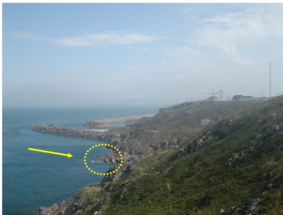
Photo 4.2.1 : Quédoy, station la plus proche de la centrale
