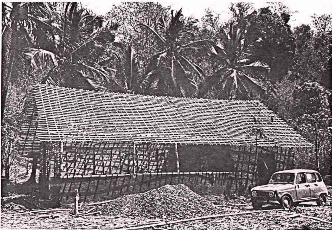
Fig. 20. - Ecole de Pêche en construction
