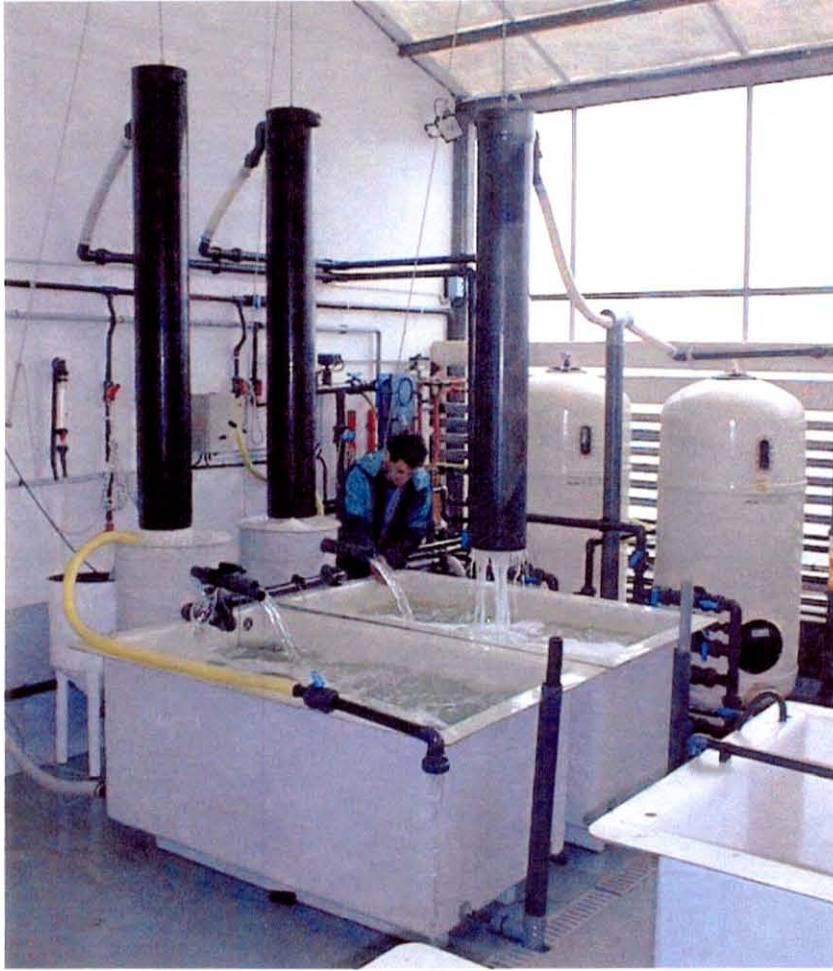
Pilote de traitement de l'eau de mer de forage, Dénitrification et élimination du fer et du manganèse.
