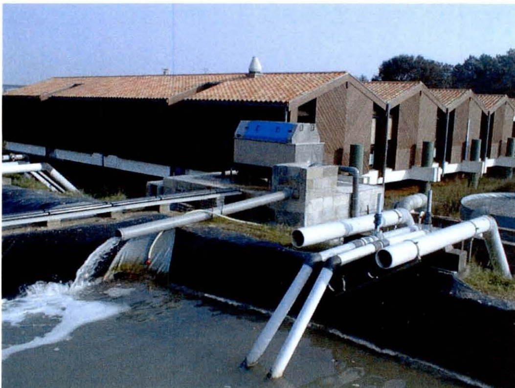
Dispositif de préfiltration de l'eau de mer par un filtre tambour (45µm).
