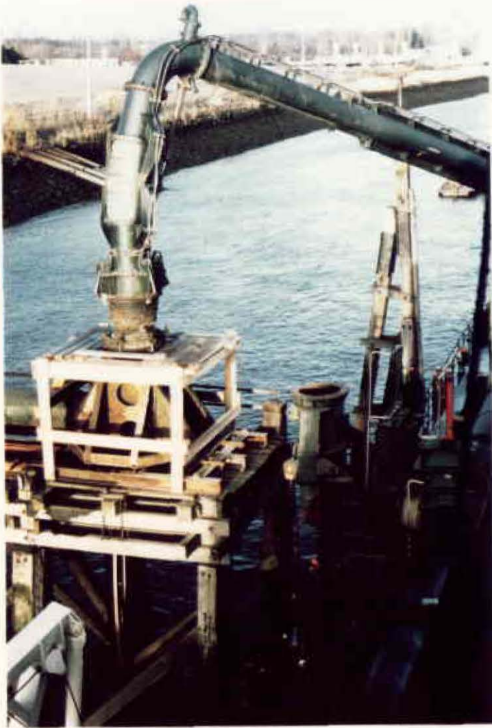
Fixation de la conduite de refoulement (Noter l'absence de fuites)
