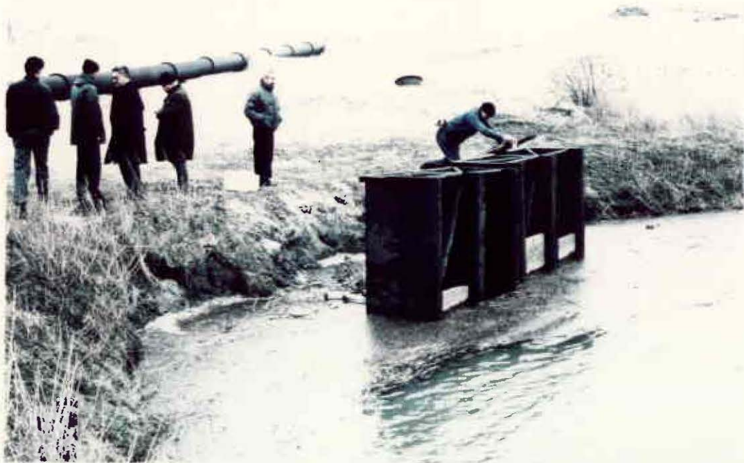
Eclusette permettant le réglage de la hauteur de vidange du bassin de decantation
