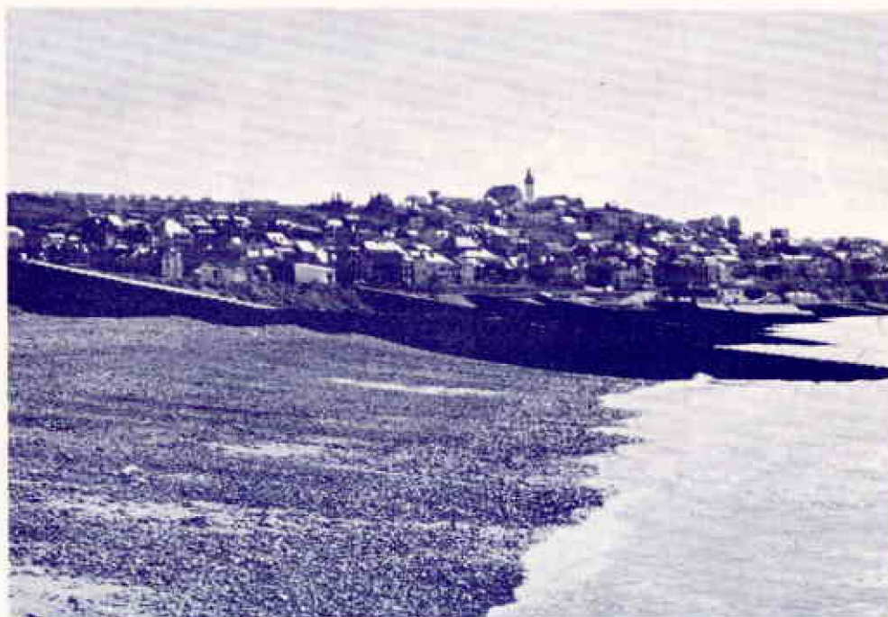
ouvrages de défense contre la mer au devant d'Ault Onival
