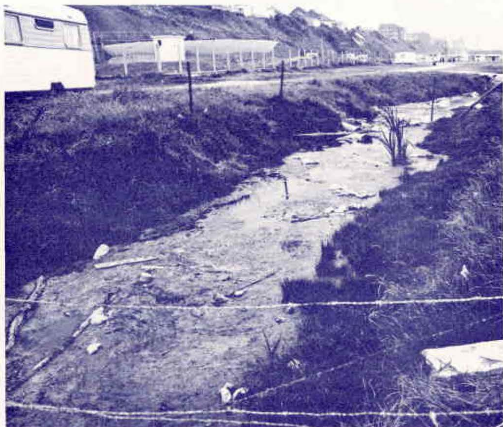
Le Haulle à la sortie de la station d'épuration d'Ault et à proximité du camping d'Onival
