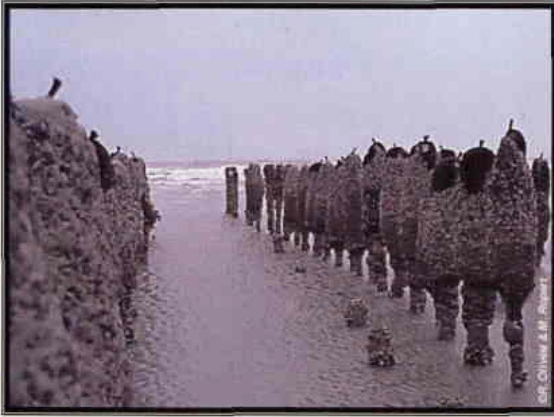
Photo 1: Vue générale des pieux touchés par le phénomène de "recouvrement"
