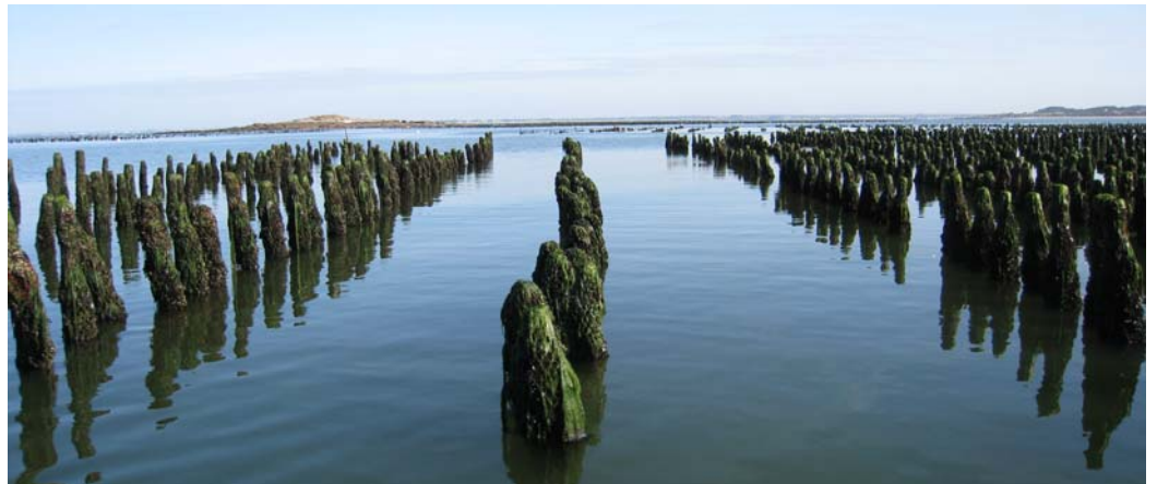
Station REMI « Le Maresclé » - baie de Vilaine
