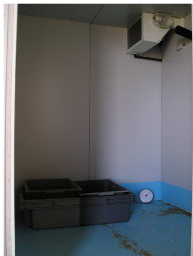
Fig. 20 : Chambre froide (3°C) équipée d'un hygroat (100%) pour la conservation de bivalves (huîtres et moules) pendant plusieurs semaines.
