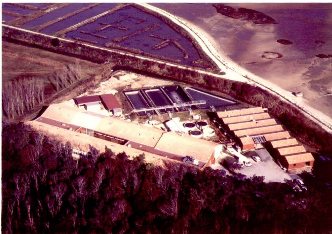
Vue aérienne du site de Ronce-les-Bains.
