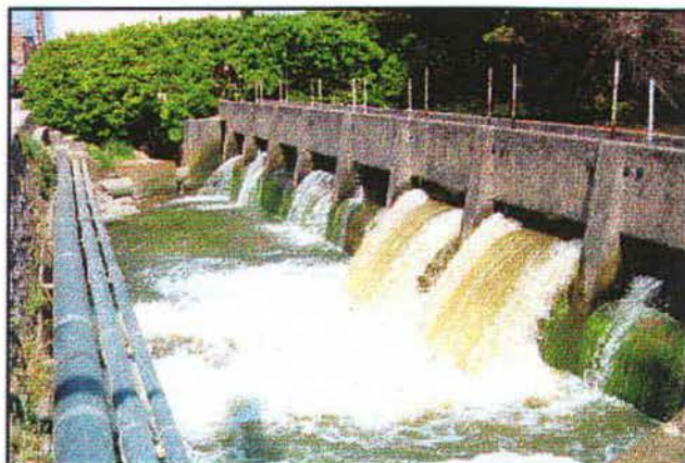
Le déversoir de l'étang de Noyal
