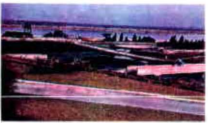
Station d'epuration - Sousse Sud
