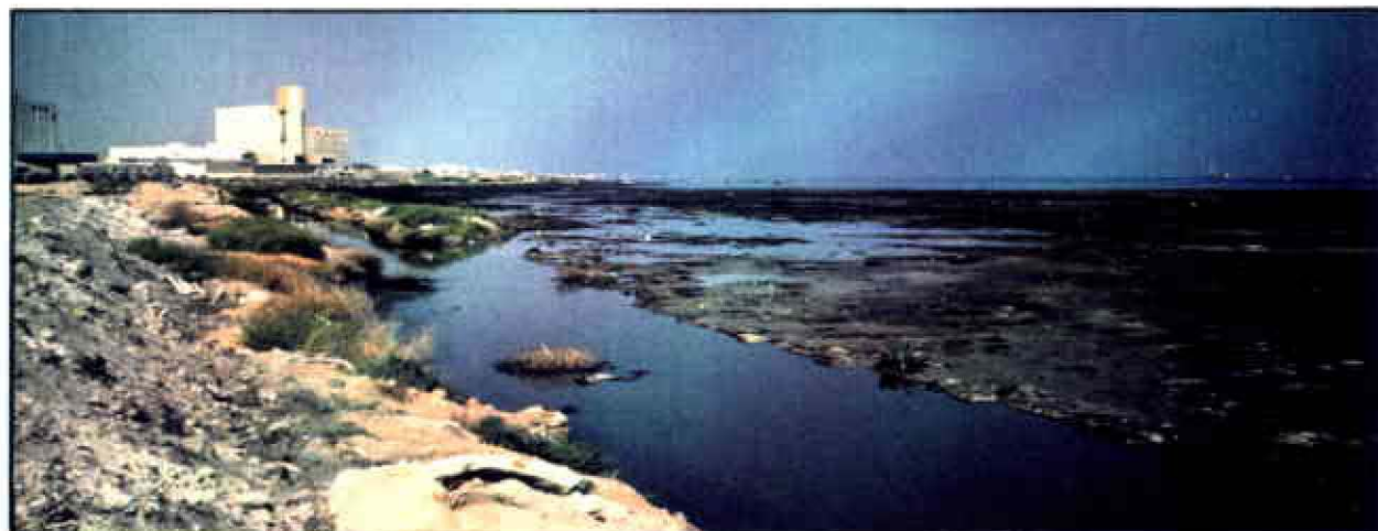
Canaux d'évacuation d'eaux industrielles, Sfax
