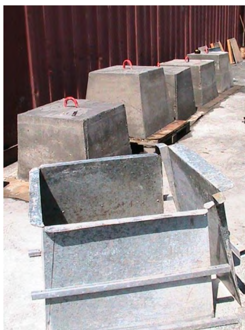
Fabrication des lests béton
