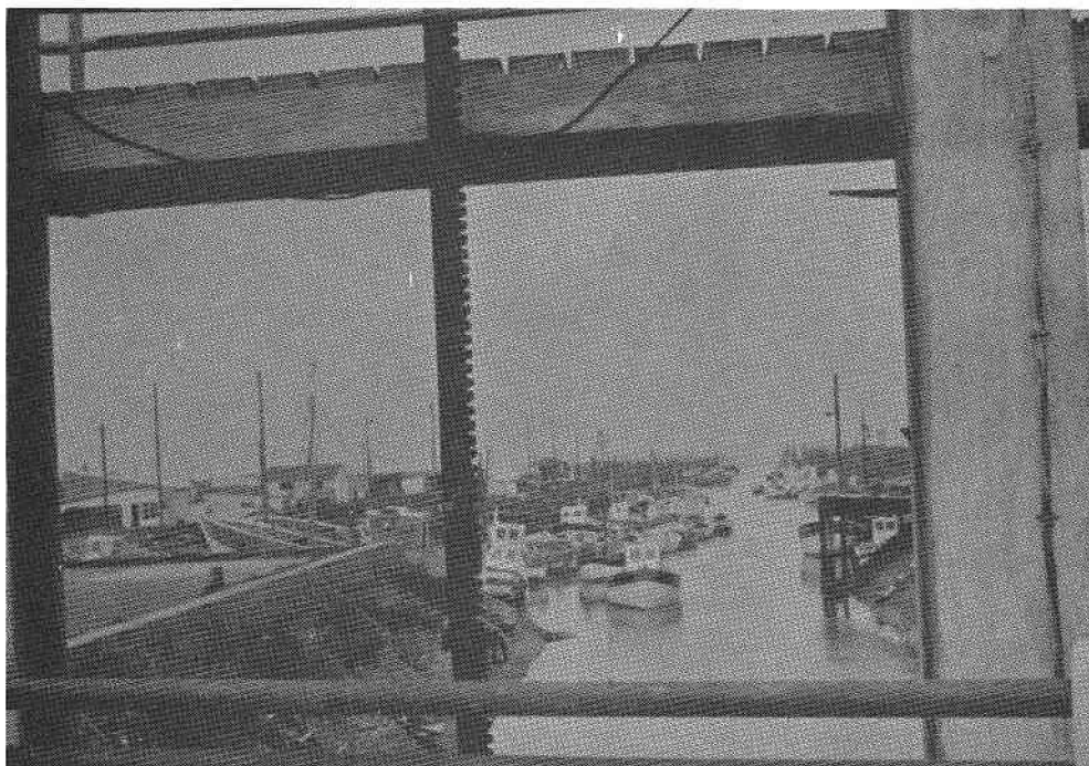
Photo 9 - Port de l'EPOIDS
