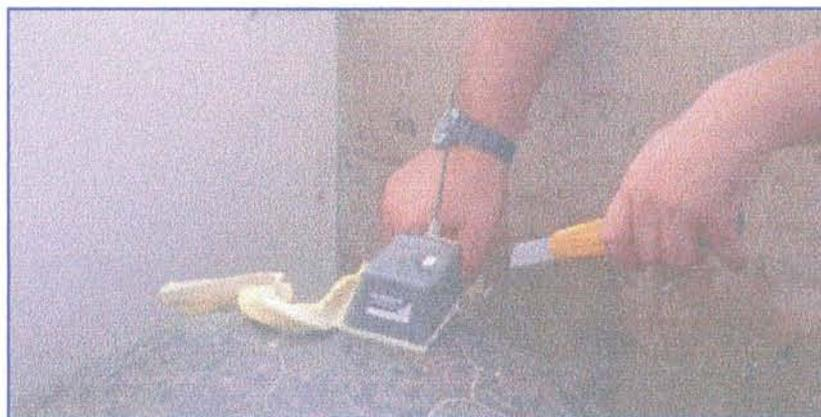
*Figure 10* : Prélèvement des excédents de silicone
