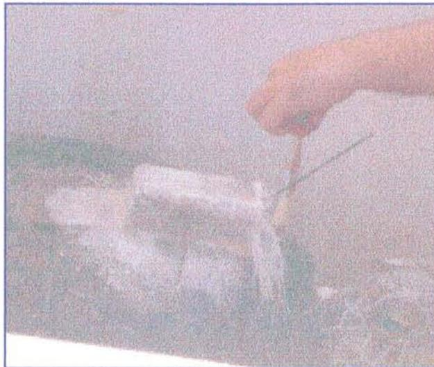
*Figure 11* : Application de la résine et de la fibre de verre.
