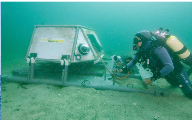
La plate-forme sous-marine en extrémité de câble
