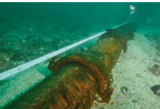
Observation du peuplement benthique le long du câble du site pilote hydrolien EDF de Paimpol-Bréhat, campagne Brebentz. © Ifremer, O. Dugornay
