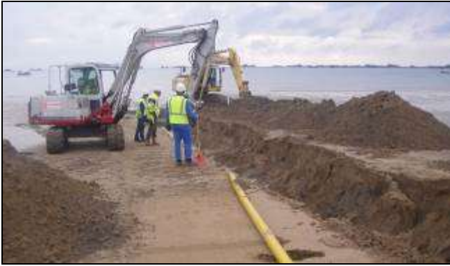
Figure 18 Travaux de pose au niveau de la plage (source : EDF)
