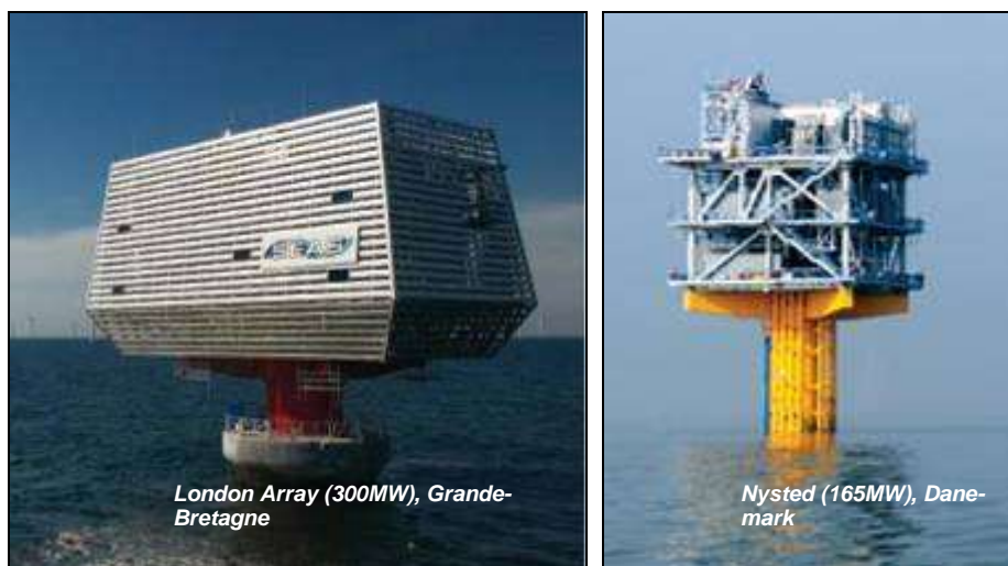
Figure 7 Exemples de plateformes de transformation du courant électrique en mer
