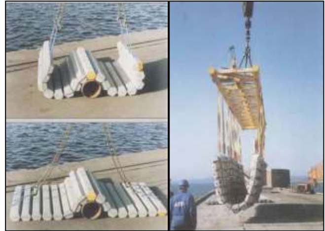
Figure 9 Matelas en béton (source : BERR 2008)
