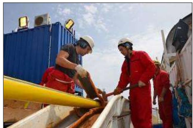
Figure 10 Mise en place des coquilles (source : EDF)
