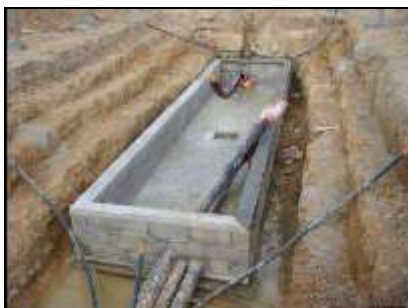
Figure 20 Boîte de jonction (source : RTE)
