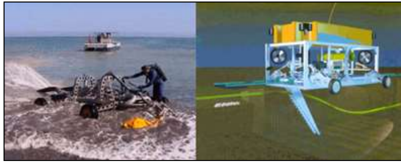
Figure 14 Technique du « jetting » (source : RTE)
