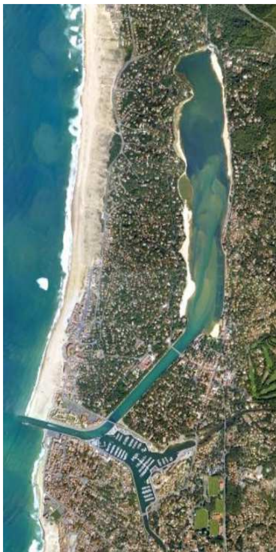
Figure 6 : Image du lac d'Hossegor en 2006 (Google Earth) et situation des bancs de sable.
