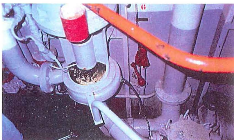
Fig.3: Pompe à ballast avec purge ouverte pour prélèvement
