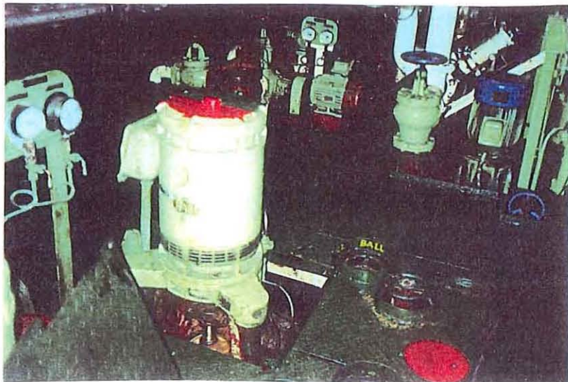
Fig.7: Pompe du circuit de ballastage dans la salle des machines(RORO de 90m)
