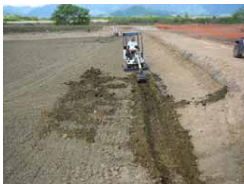
Photo 11 : réalisation de drains sur le pourtour des bassins
