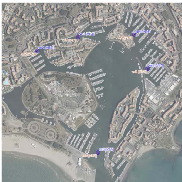
Figure 14 Localisation des points de prélèvement eaux et sédiments dans le port du Cap d'Agde (source : DREAL-LR, janvier 2013)
