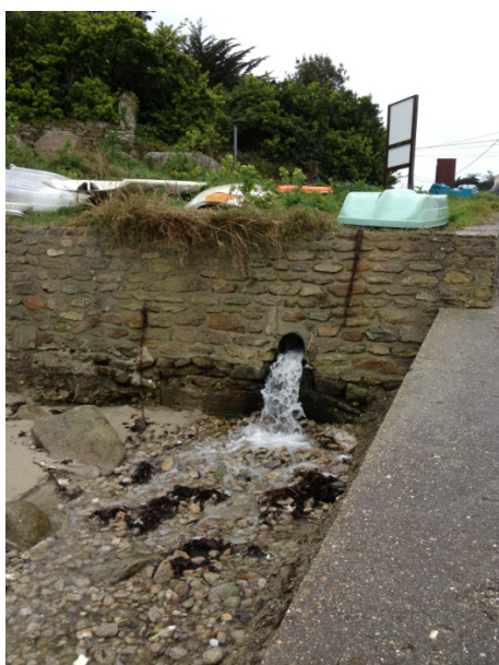
Figure 10c : émissaire de rejet des eaux pluviales
