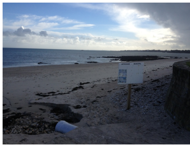
Figure 9 b : Emissaire d'eaux pluviales
