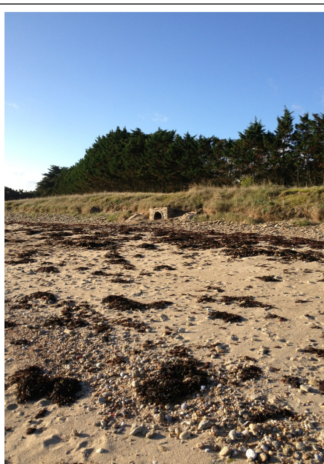
Figure 11b : exutoire d'eaux pluviales
