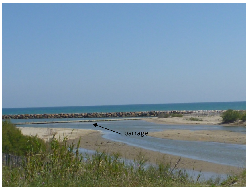
Figure 2 : Vue du barrage (intégrant les vannes) en sortie de grau
