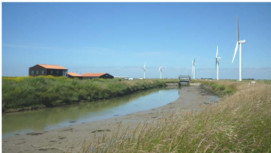
Canal d'alimentation du polder conchylicole de Bouin
