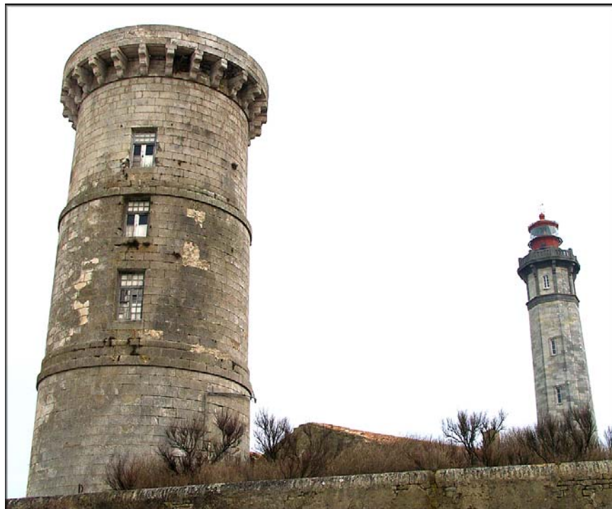
Ile de Ré - Phares des baleines (l'ancien au premier plan et l'actuel)
