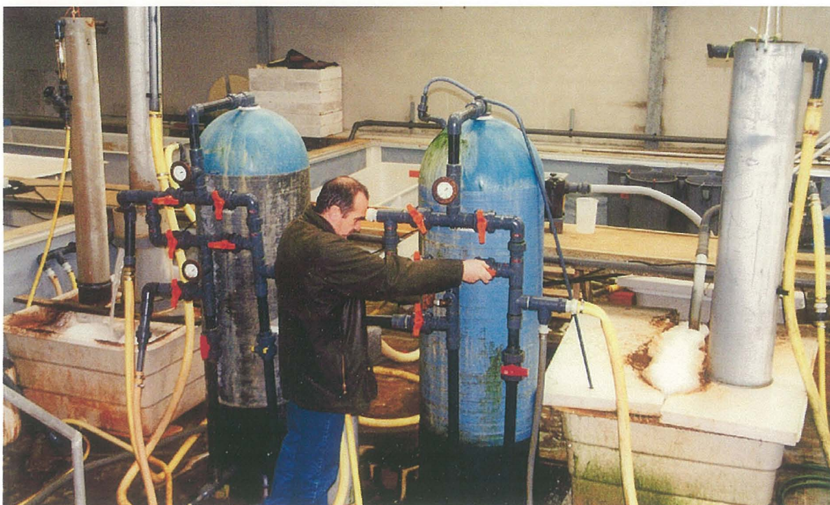
Photographie 1 : Vue d'ensemble du pilote de traitement de l'eau salée souterraine.
