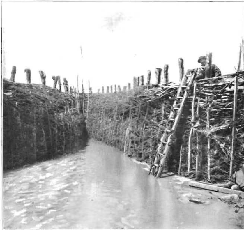
Fig. 138. Pêcherie fixe. — Vue intérieure. le couloir terminal. (Remarquer le colmatage à peu près hermétique des parois par les algues.)
