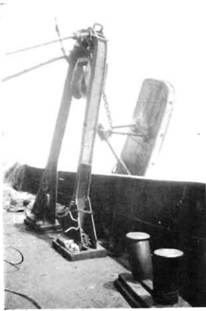
Fig. 16. La ferme et le panneau de chalut.
