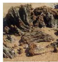
Boules isolées dégradées (B.I.D.)
