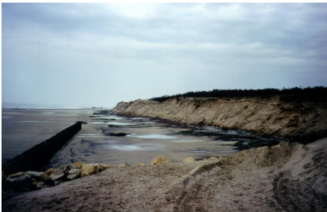
**Photo 5 : Extrémité Nord de l'ouvrage longitudinal et rangée Nord de ganivelles hydrauliques. L'Amélie-sur-Mer (Photo IFREMER)**
