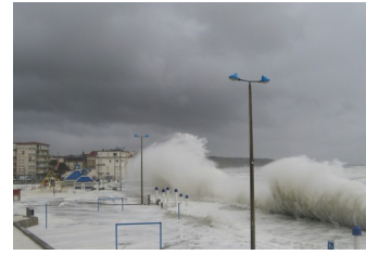
Photo 6 : Tempête sur la digue.
