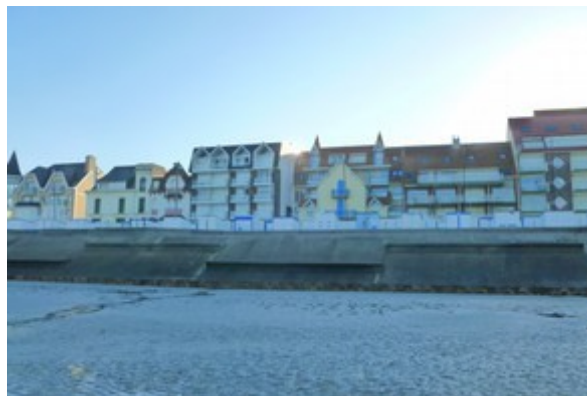
Photo 8 : Digue de Wimereux protégée par un perré (Photo F. Vérin).
