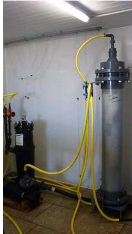
Figure 36 : Colonne d'adsorption SODABO avec filtre cartouche 5 µm en amont et réacteur UV en aval
