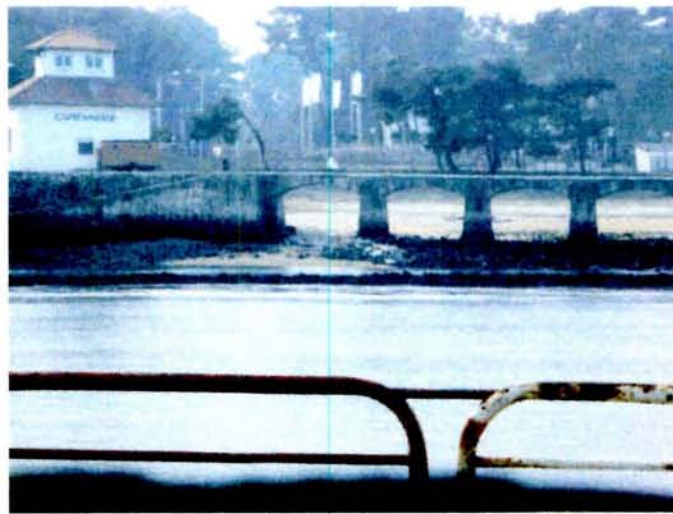
Photo 5 : point A1, Adour marégraphe
