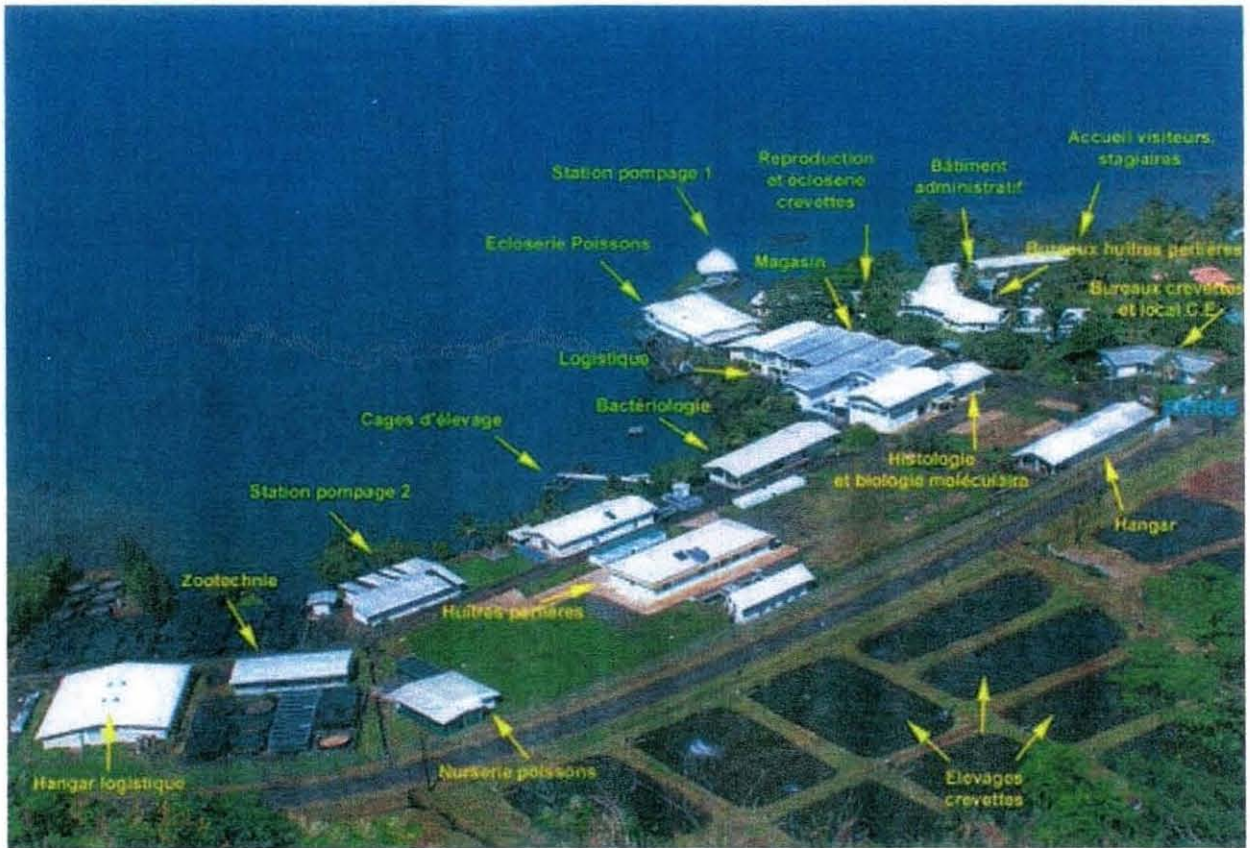
Figure 1 : Vue aérienne du COP (Source www.futura-sciences.fr )
