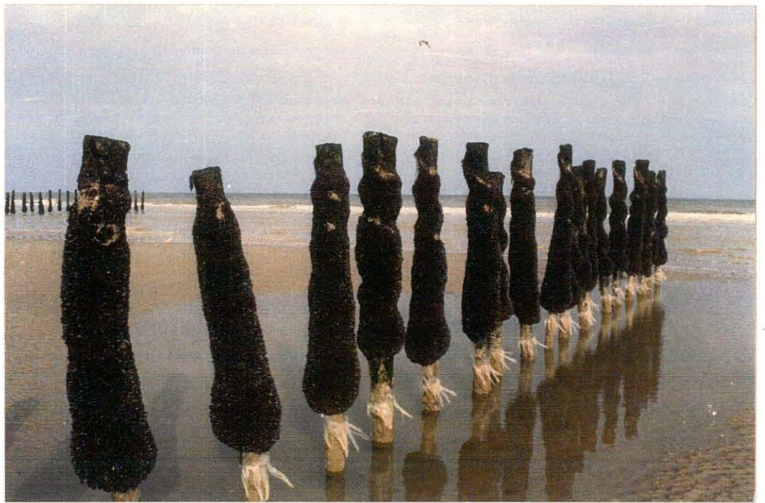
PHOTO 3 : Protection des pieux par des feuilles plastiques (Tahitiennes).
