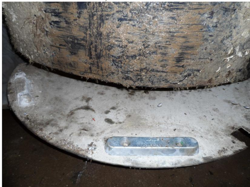
Figure 8. Remise en place d'une anode anticorrosion sur le flotteur (au premier plan). A gauche, à l'arrière-plan, anode après plusieurs mois de déploiement.
