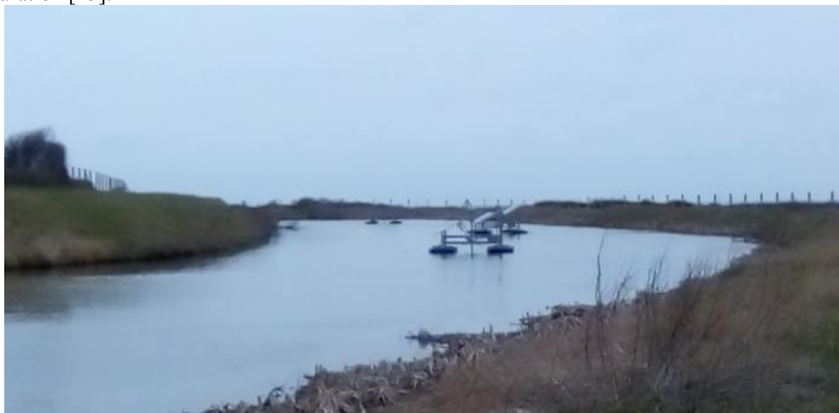
Photo 1 : brassage de l'eau du premier bassin de la station d'épuration d'Audresselles (photo F.Vérin, LER/BI).
