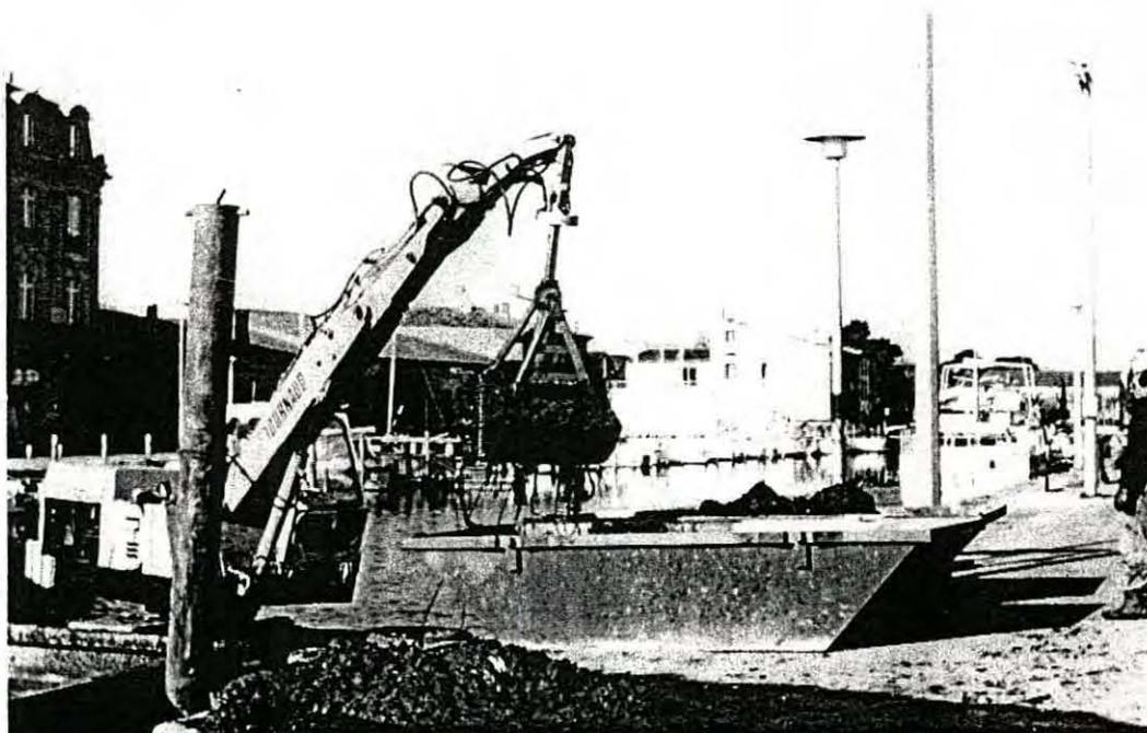
Fig. 30b : Remplissage des containers placés sur le quai du port de Marseillan.
