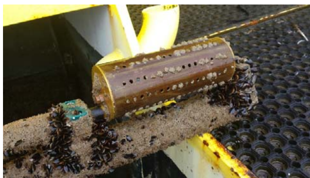
Figure 11. Crépine de prélèvement en sub-surface
