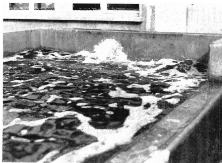
FIG. 36. — Alimentation en eau d'un bassin d'épuration de la station du « Dauphin » à Sète.
