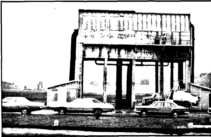
Photo 2 - Tour d'aération (Mactaquac)
