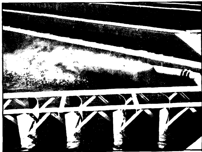
Photo 30 - Distribution de granulés par système pneumatique
