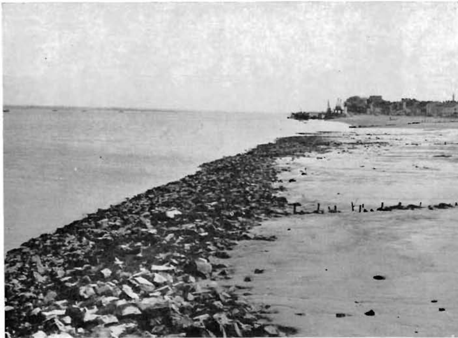
FIG. 3. — Digue en aval du phare du Haut-Paimbœuf.
