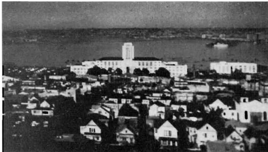
FIG. 57. — Une partie de la rade de San Diégo, première base navale des Etats-Unis.
