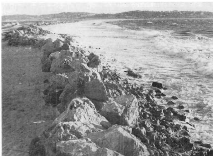
FIG. 3. — Enormes blocs de calcaire mis en place pour protéger la route après dispersion des gabions posés en 1968 et 1969.
