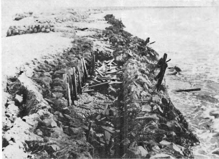
FIG. 2. — Partie médiane du tombolo ouest (nov. 1969). Côté mer : pierres enserrées dans du grillage, maintenues avec des pieux métalliques (installés en 1968 afin de protéger la dune littorale) ; en arrière : dispositif du même type mis en place en 1969 ; premier plan : début d'effondrement des pierres et de la dune.
